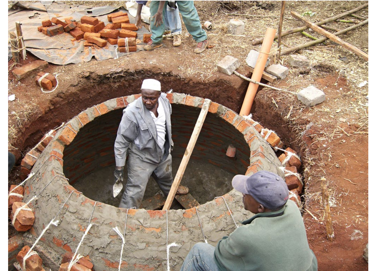
Biogas aus Kleinanlagen reduziert den Einsatz fossiler Brennstoffe in Kenia.
